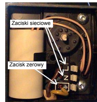
Rys. Podłączenie przewodów do pompy C.O.
